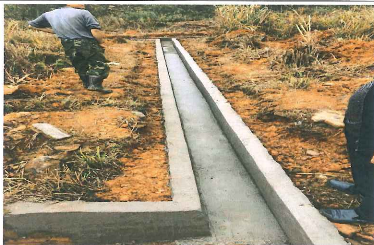
排洪沟修复后照片
