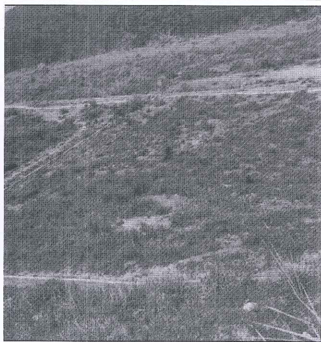
图 3.1- 3 堆积坝外坡植草护坡
