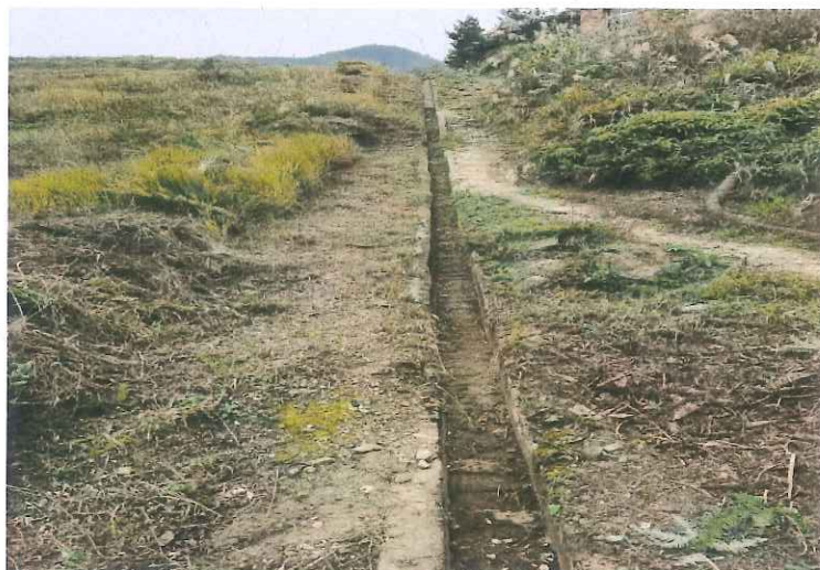
排洪工程整改后照片
