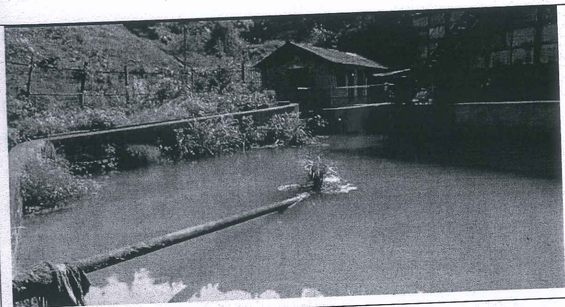
尾矿水处理设施
