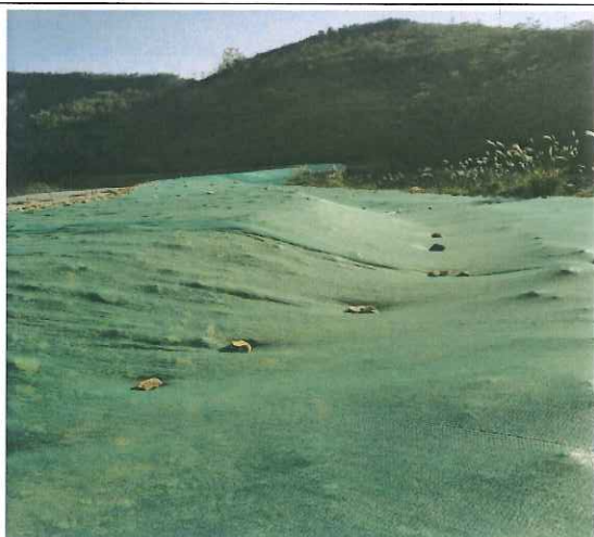
尾矿库堆积坝边坡覆石、覆土
