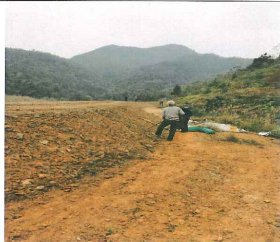
尾矿库堆积坝边坡覆石、覆土
