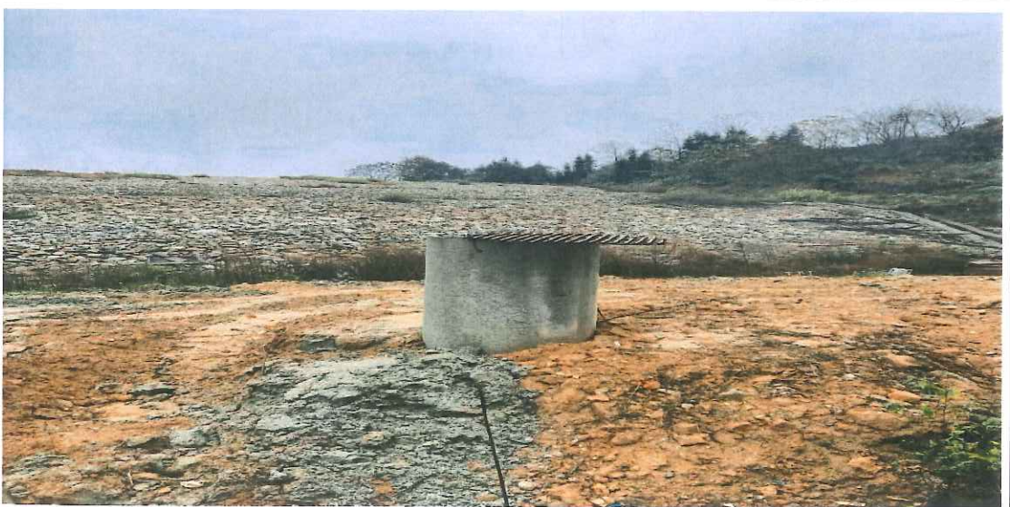
地下水观测井
