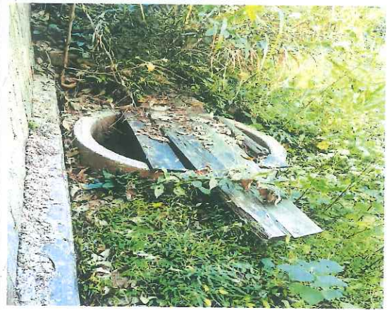
地下水监测井
