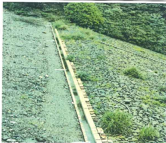
尾矿库堆积坝边坡覆石
