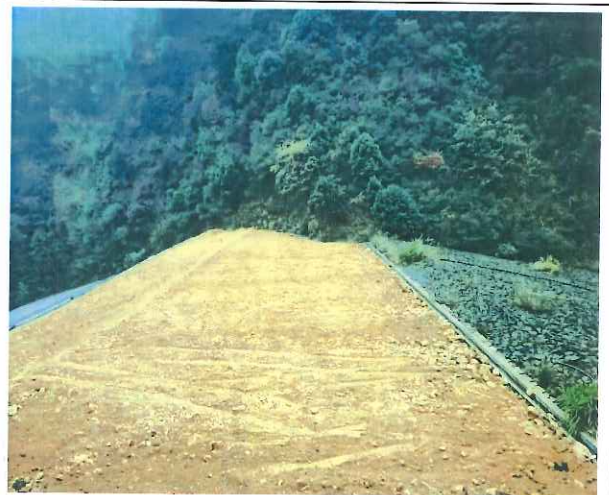
尾矿库堆积坝边坡覆土
