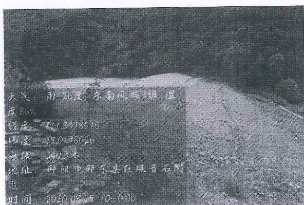
图3-1 尾矿库堆积坝
