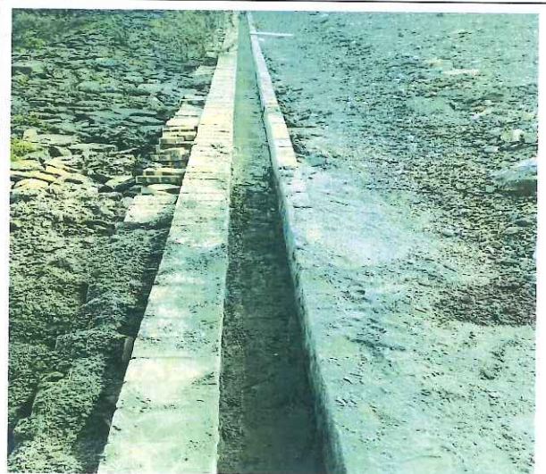
尾矿库堆积坝坎肩沟
